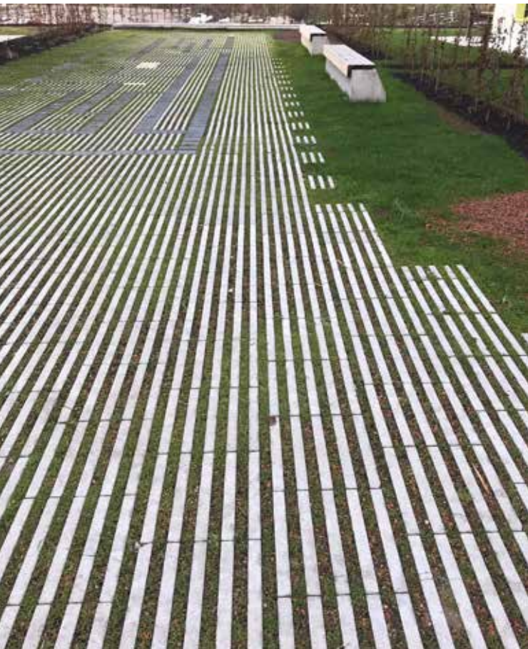
SCADA Rasenliner Platte nativo Grau
