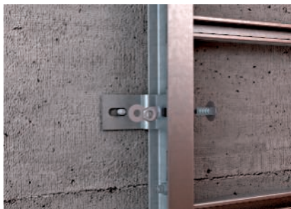
Montāža ar pieskrūvētiem stiprinājumu leņķiem
