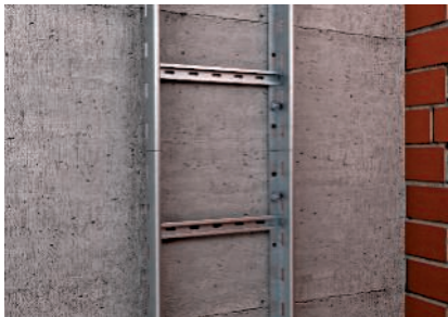
Vertikālo trepju tieša montāža pie monolītas sienas
