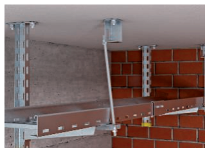
Vītņstieņa iekarināšana ugunsdrošajās apskavās
