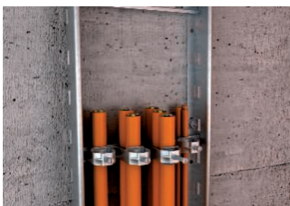
Atsevišķa kabeļa vai kabeļu kūļa nostiprināšana ar kabeļu apskavām
