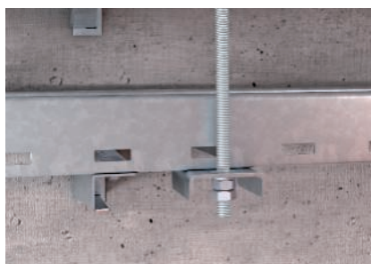
Vertikāla vītņstieņa piestiprināšana pie pievienojuma detaļas
