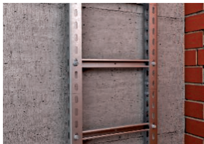
Vertikālas trases tieša montāža pie monolītas sienas
