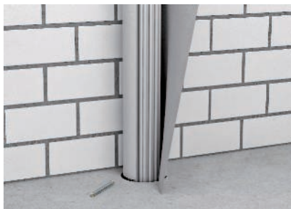
Ugunsdrošības bandāžas uzstādīšana
