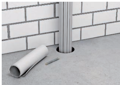
Kabeļa ugunsdrošības izolācijas sagatavošana
