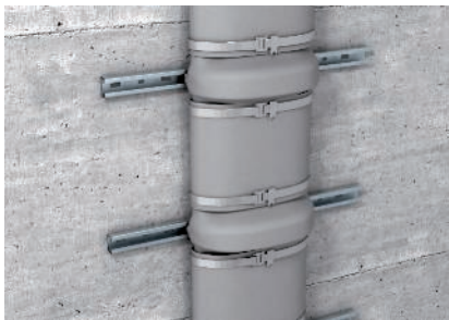
Bandāžas nostiprināšana ar metāla spriegošanas lentām instalācijā ar sliedēm
