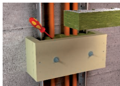
Minerālvates pildījums elastīgam aizpildījumam ar kabeļiem
