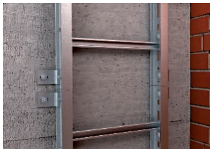
Vertikālo trepju tieša montāža pie monolītas sienas
