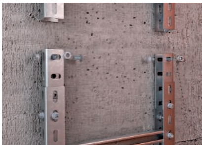
Salaidumu vietas konstrukcija ar pieskrūvētu savienotāju
