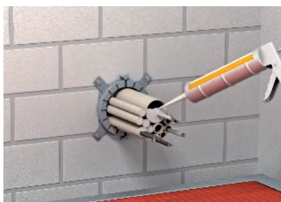
Cauruļu galu aizpildīšana ar izolējošu putu slāņa aģentu DSX
