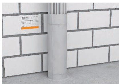
Atlikušās atveres aizpildīšana izolācijā ar javu un marķējuma plāksnītes uzstādīšana
