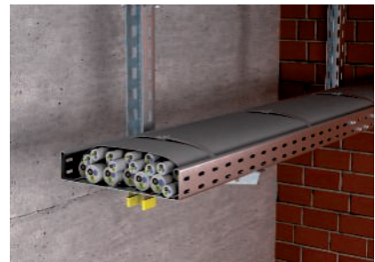
Kabeļu saišķu noklāšana ar bandāžu nesošajās sistēmās
