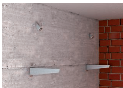
Balsteņu un pievienojuma būvdetaļu montāža pie sienas
