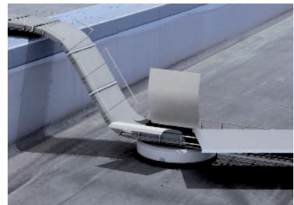
Izmantošana, virs uguns mūra instalējot saules bateriju elektrības vadus
