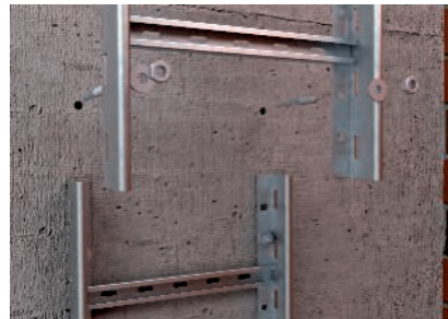
Salaidumu vietas konstrukcija bez savienotāja
