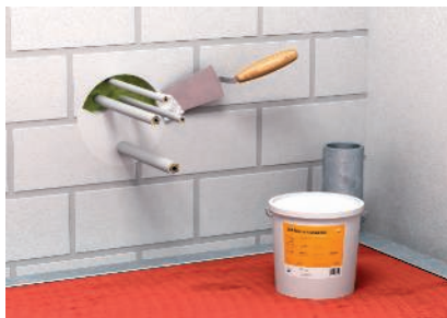
Abpusējs virsmu pārklājums ar izolējošu slāņa veidotāju DSX (minimālais biezums katrai 1 cm)
