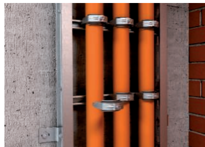
Kabeļu instalācija ar kabeļu apskavām pie vertikālo trepju spraišļiem
