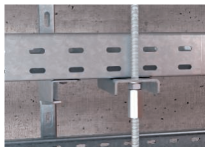
Vītņstieņu nostiprināšana pie kanāla vairāku līmeņu instalācijās
