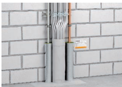
Ugunsdrošības bandāžas uzstādīšana ar nulles attālumu līdz Rockwool Conlit cauruļu ugunsdrošības izolācijai
