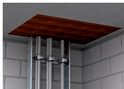
Precīza un līdzena bloku montāža griestu caurvadā
