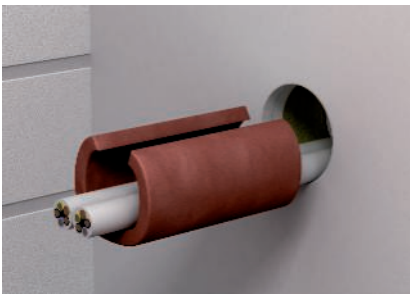
Apvalkcaurules pārgriešana, kad kabeli jau ir instalēti
