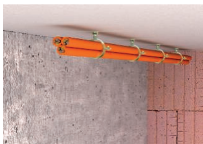
Kūlī apvienotu kabeļu instalēšana pie griestiem
