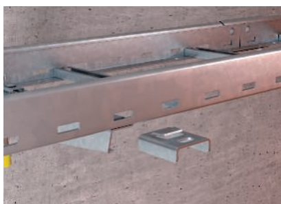
Pievienojuma detaļas uzspraušana uz trepju malas apakšējās daļas
