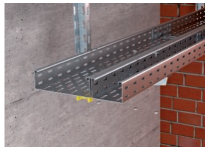
2 kabeļu kanālu kopēja montāža uz viena balsteņa
