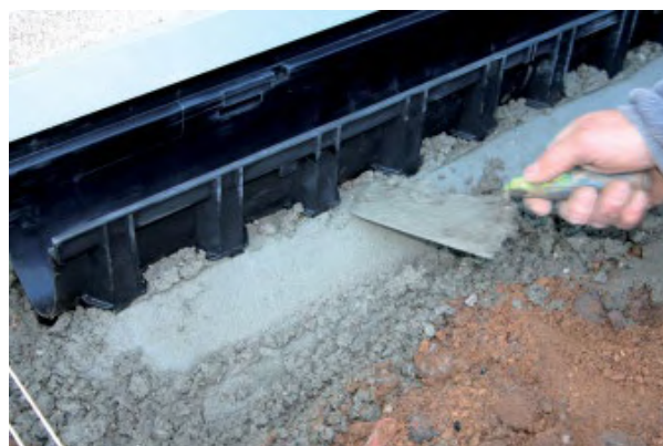
Teknes jāklāj uz betona pamatnes
