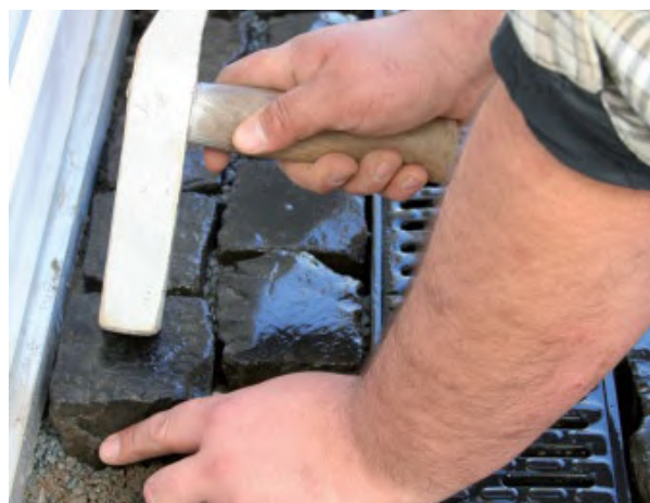
Montāža bruģa segumā
