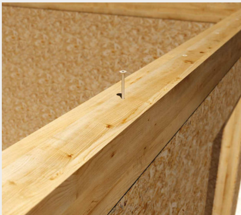
^ Karkasa konstrukcijas balsta sijas stiprināšana.
