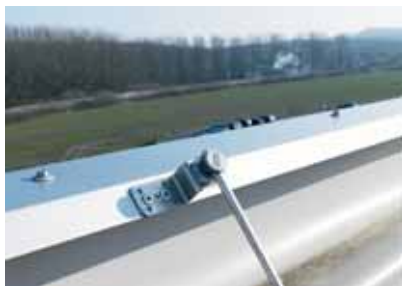
Atikas pievienošana pie zibensaizsardzības sistēmas
