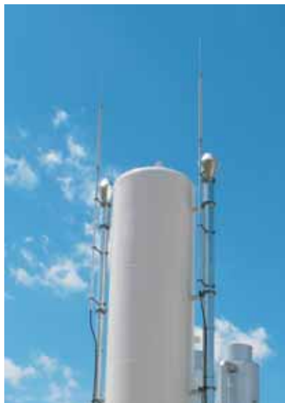
isCon® sistēma biogāzes stacijas izmešu zonā
