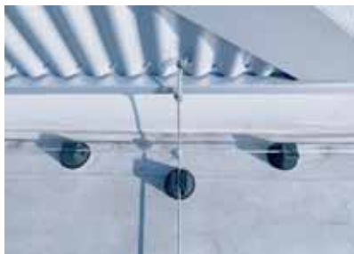
Metāla fasādes pievienošana pie zibensaizsardzības sistēmas
